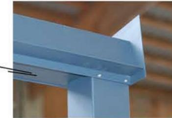
9. Dach ausrichten (Diagonalen messen)
