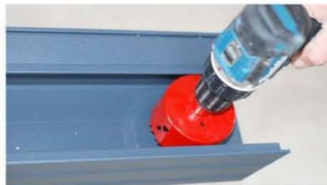
5. Rinnenprofil bohren, Blattfänger einbauen (Silikon), Rinnenprofil auf Stützen legen und festschrauben.
